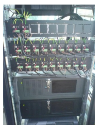
Λεπτομέρεια από το κεντρικό ικρίωμα Συστήματος Κλειστού Κυκλώματος, Ελέγχου Πρόσβασης και Ωρομέτρησης Προσωπικού στον Ασπρόπυργο Αττικής (40 κάμερες, 20 τερματικά ελέγχου, 4 σημεία συγκέντρωσης κινδύνου)
